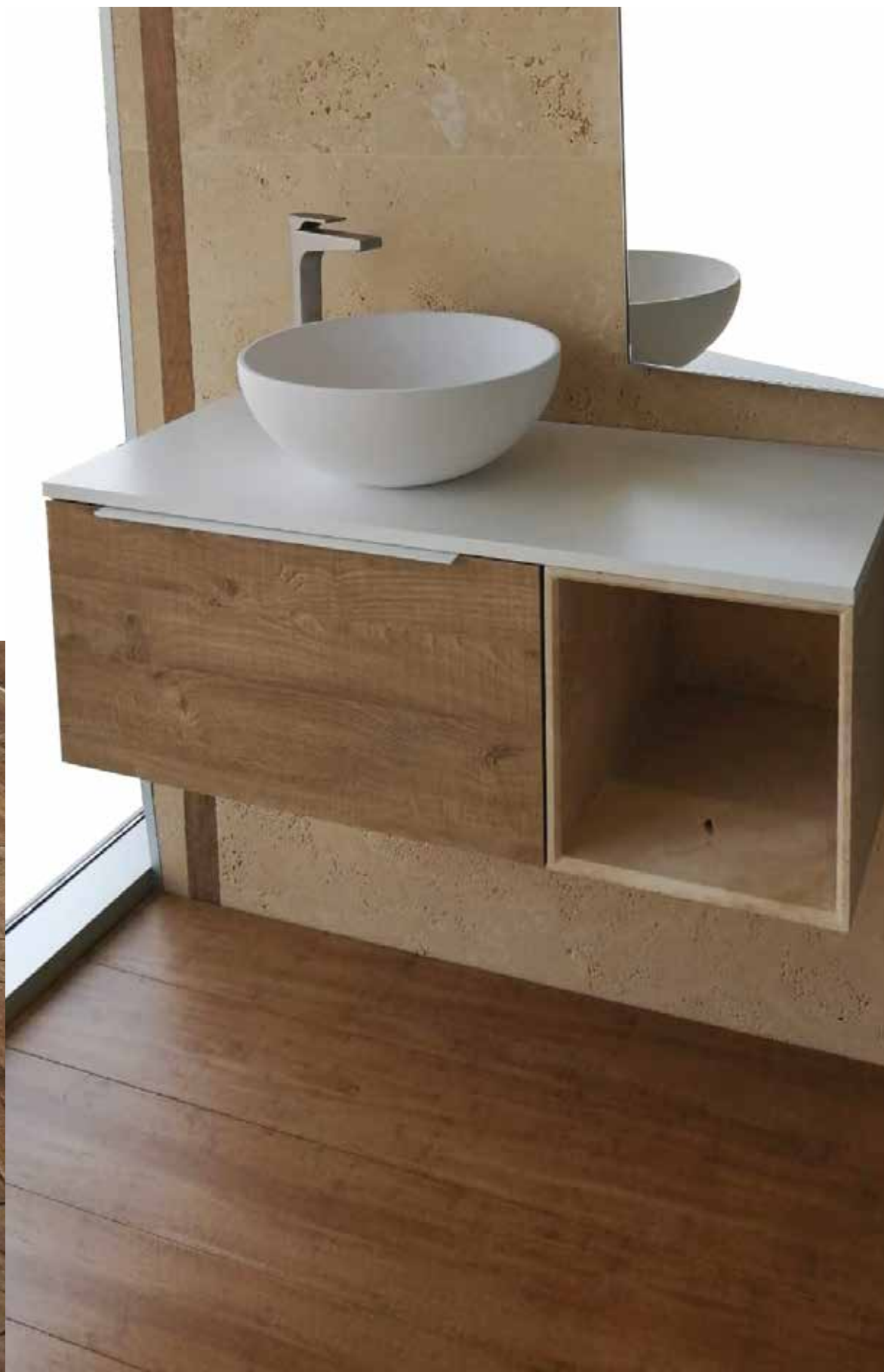
REALIZZAZIONE DI BAGNO IN TRAVERTINO CON INSERTI E PAVIMENTO IN BAMBOO
